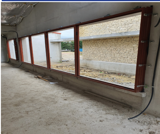
Pose des fenêtres & béton ciré à droite
