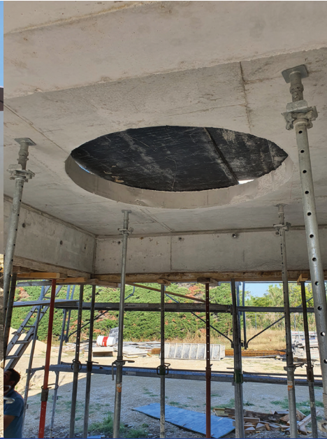
Ouverture puits de lumière
