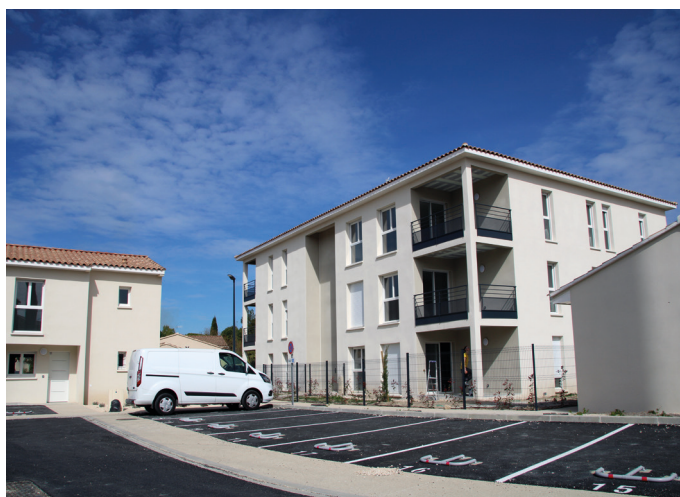
Immeuble à logements sociaux avec places de parkings
